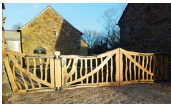
Même le bois tordu peut trouver sa place ! (Châtaignier, réalisation : A. Receveur, menuisier Logonna-Daoulas)
