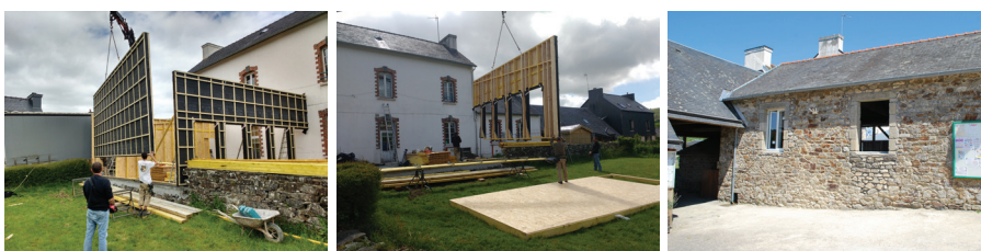
Les travaux de l'école v
