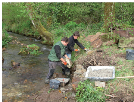
La réalisation des piles en maçonnerie
