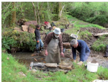
Pose de l'ancien pont en pierres bleues
