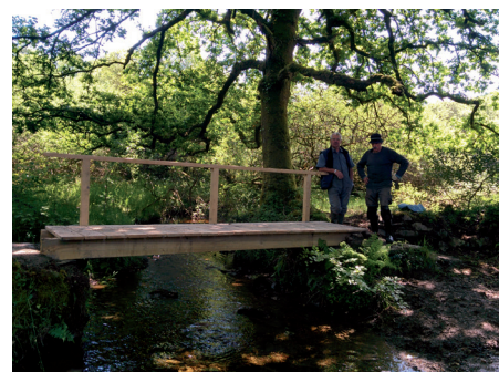
La nouvelle passerelle de Bodenna
